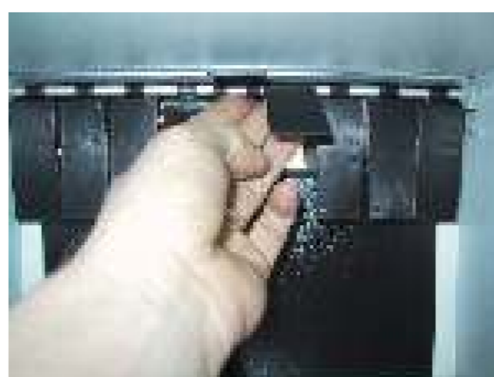
10. Montage van beugel (met of zonder lamellen)
